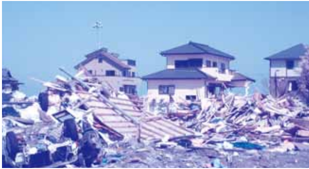
津波によって1階部分が破壊された住宅(いわき市内)
